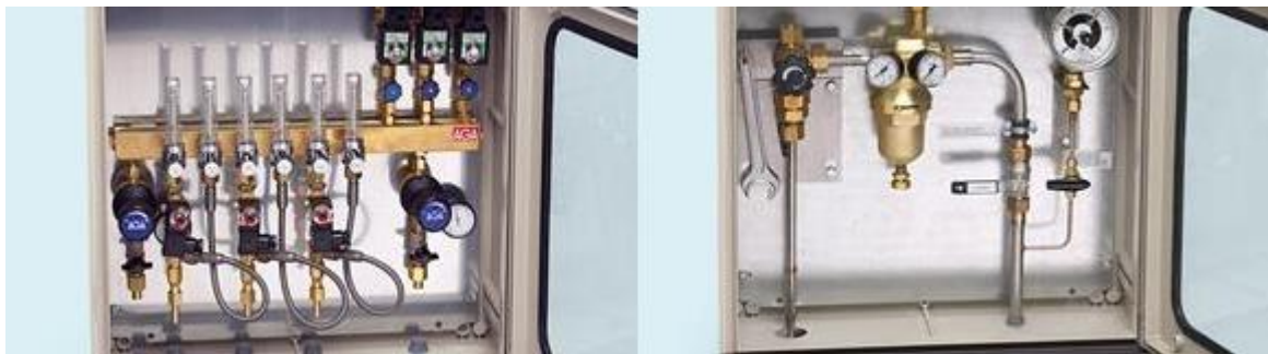
Joonis 2. Linde Gaasi lahendus hapniku doseerimiseks ja avari-hapnikuvarustuseks
