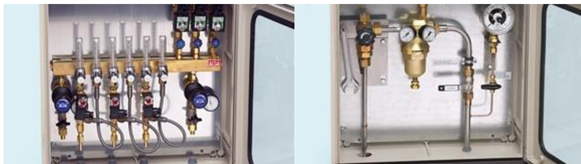
2. attēls. Linde Gas O 2 plūsmas/ dozēšanas vārsti un avārijas O 2 pievades sistēma.
