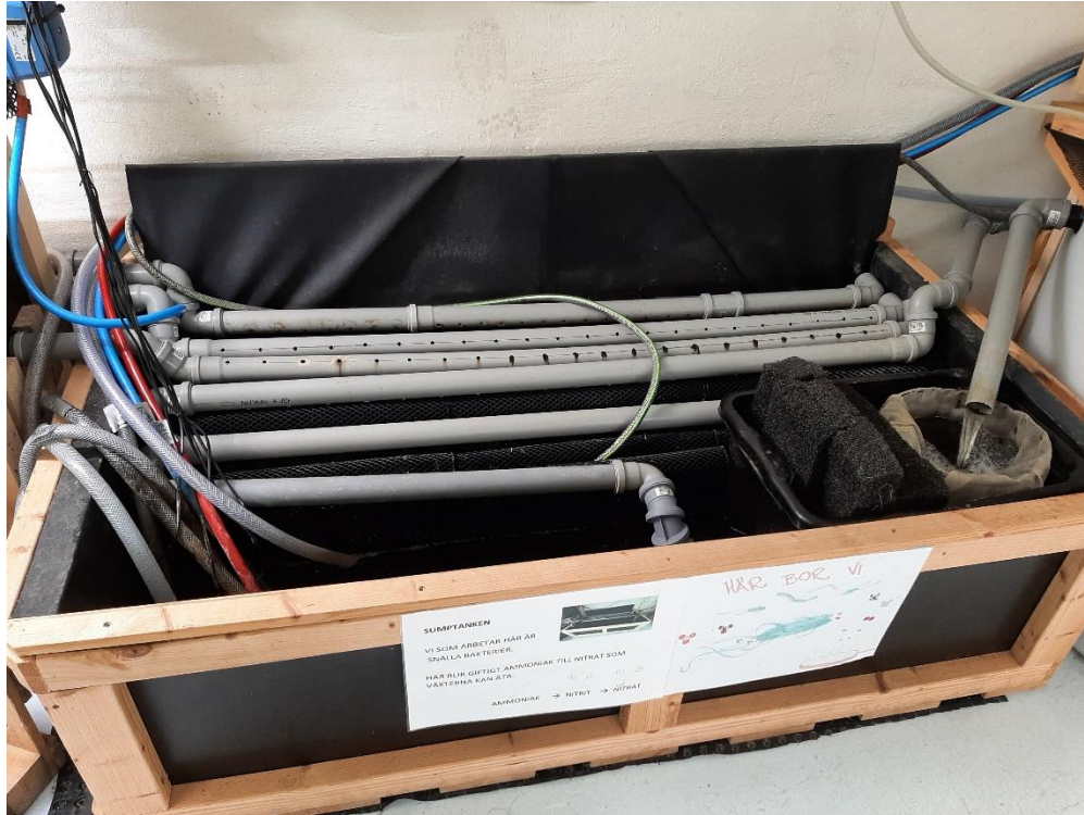
Kuvio 7. Biofilteri akvaponisessa viljelyjärjestelmässä, Campus Roslagen, Norrtälje.
