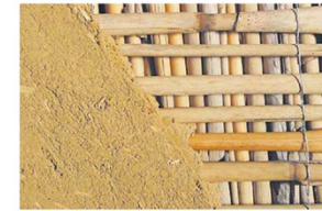
Hiss Reetin rappausmattota ristin kiinnitettyä sisältäen paksun savirappauksen vahvistamiseksi [4]
