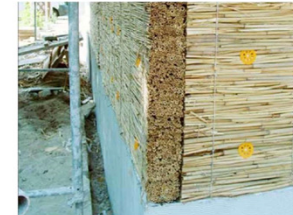
Hiss Reetin ruokolevy kiinnitetty kiviseinän lyöntikilaa-ankkureilla lämmöneristeeksi kalkkirappauksen alle [4]
